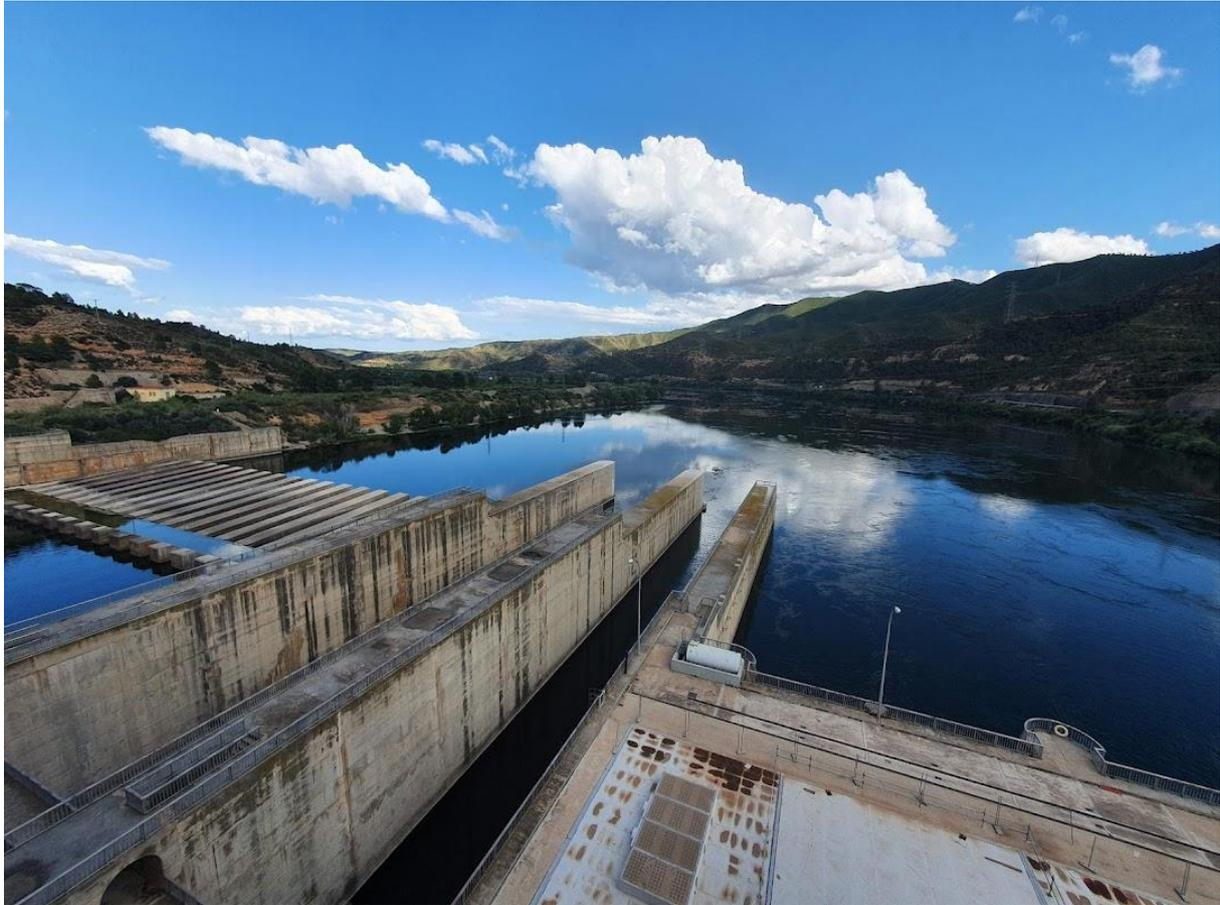
Figura 39: Órganos de desagüe de la presa de Ribarroja y situación del río Ebro aguas abajo de la misma.
